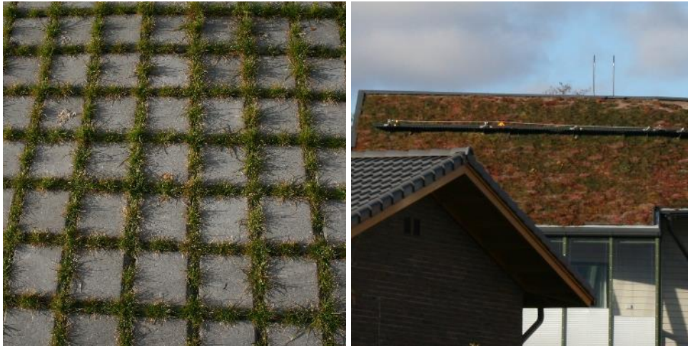
Kuva 8 Esimerkkikuva läpäisevästä pinnasta sekä viherkatosta (Kuva: AFRY Finland Oy)
